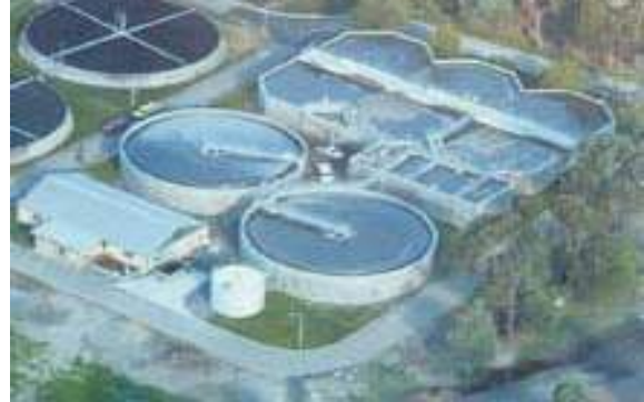
ਚਿੱਤਰ 10.7 ਗੰਦੇ ਪਾਣੀ ਵਿੱਚ ਉਪਚਾਰ ਸੰਯੰਤਰ ਦਾ ਆਕਾਸ਼ੀ ਚਿੱਤਰ (Aerial view of Sewage Plant)
