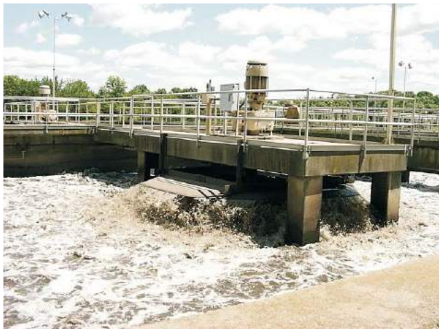
ਚਿੱਤਰ 10.6 ਸੀਵੇਜ਼ ਟ੍ਰੀਟਮੈਂਟ ਸੰਯੰਤਰ ਹਵਾ ਯੁਕਤ ਟੈਂਕ (Area Tank of Sewage Treatment Plant)
