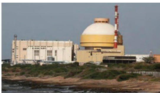
Atomic Power Plant (Kalpakkam)
